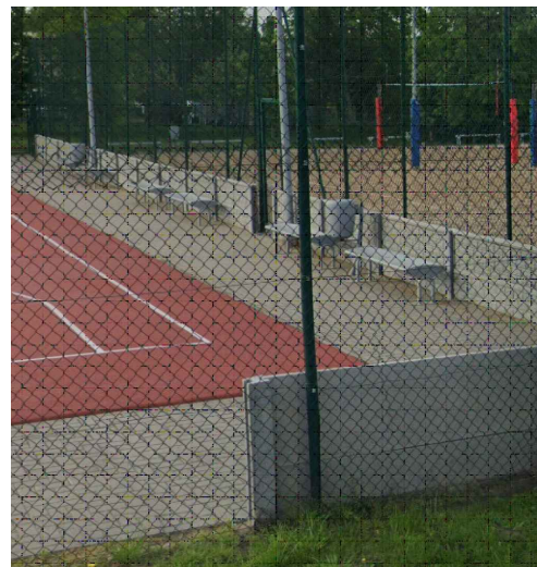
surenkamos betoninės sienelės PVZ.
